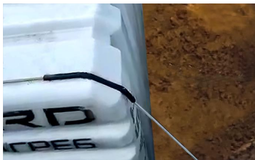
Рисунок 5. Заделка троса
